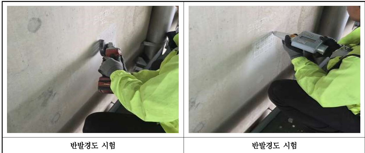
【사진 44.4.2】 반발경도시험 현장사진
