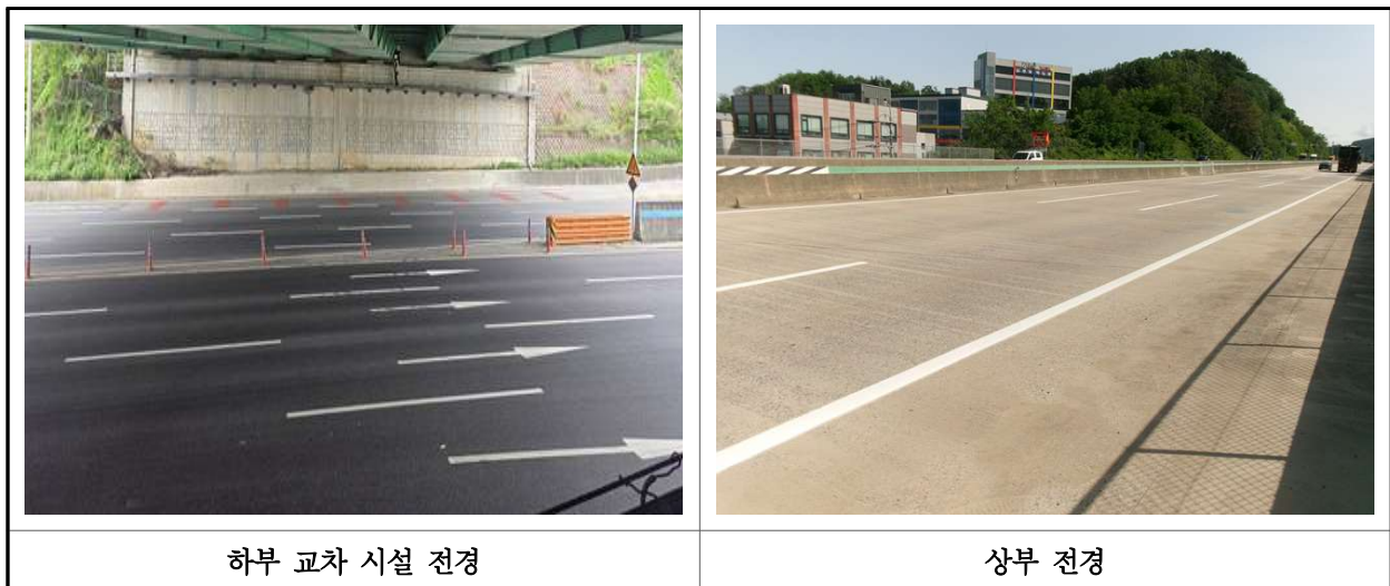
【사진 44.2.1】 주변환경 및 하중변화 전경
