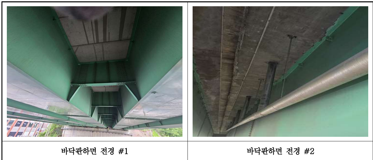
【사진 44.3.2】 바닥판하면 전경
