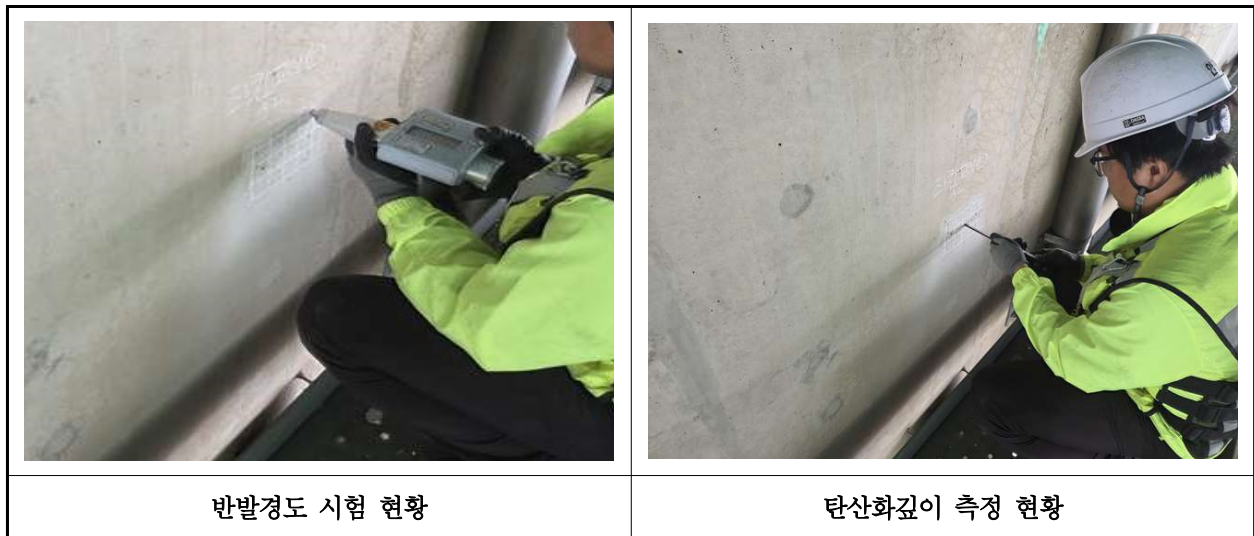
【사진 44.4.1】 콘크리트 내구성조사 현황
