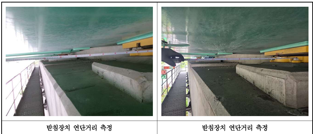
【사진 44.3.13】 교량받침장치 연단거리측정
